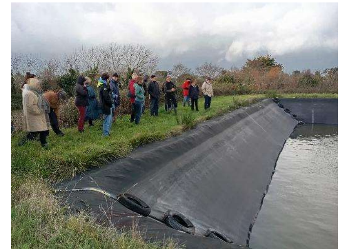
Réserve d'eau à usage agricole, Yeu
